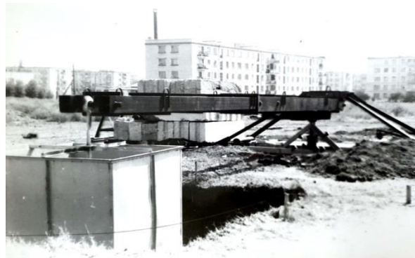
Общий вид установки МИСИ (ныне НИУ МГСУ) с конструкцией рычага в виде составной металлической стрелы и пространственной металлической фермы для проведения статических испытаний натуральных свай и моделей фундаментов
