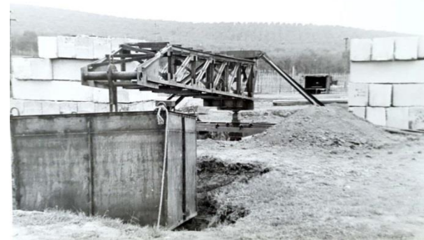
Общий вид установки МИСИ (ныне НИУ МГСУ) с конструкцией рычага в виде составной металлической стрелы и пространственной металлической фермы для проведения статических испытаний натуральных свай и моделей фундаментов
